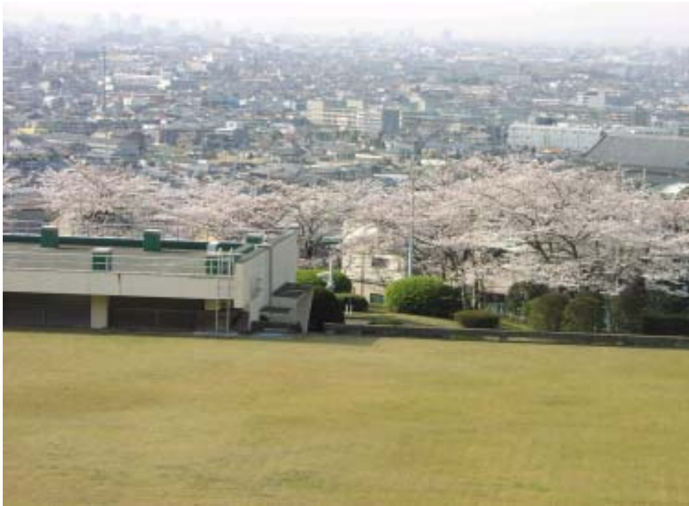
南部低区配水池
