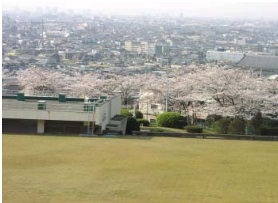
南部低区配水池
