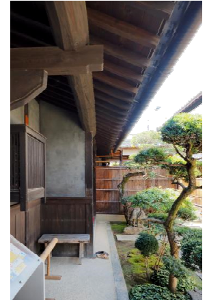
▲ 深い軒の出で日差しを遮る旧植田家住宅の西面
