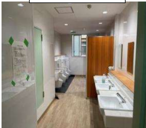
3階：南館トイレ
