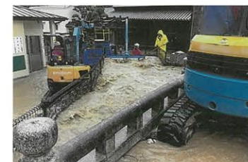
八尾市での被害(大西川)
