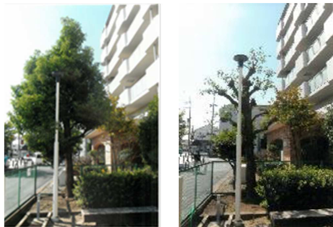
写真 照明灯に影響している樹木の剪定
