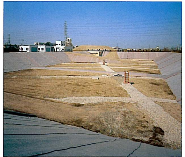
埋立処分地の全景
