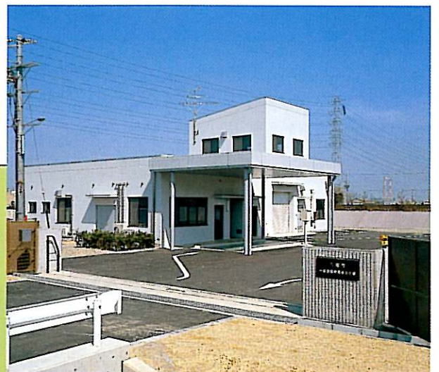
浸出水処理施設の全景
