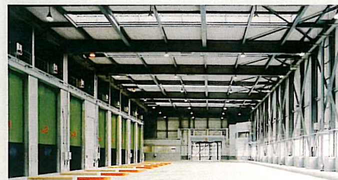
㉕投入扉、プラットフォーム…収集したごみは9面の投入扉からごみピットに投入されます。
