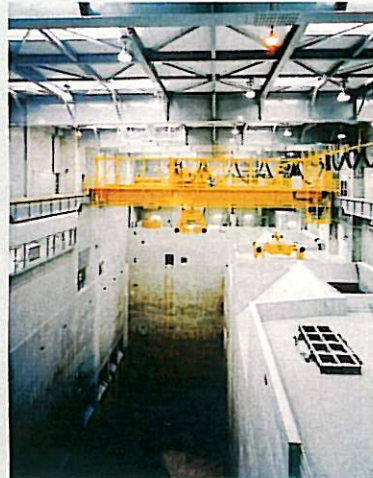
㉓ごみピット・㉔ごみクレーン…ごみピット容量約11,000m 3 、ごみクレーンつかみ量約5t(1回)。
