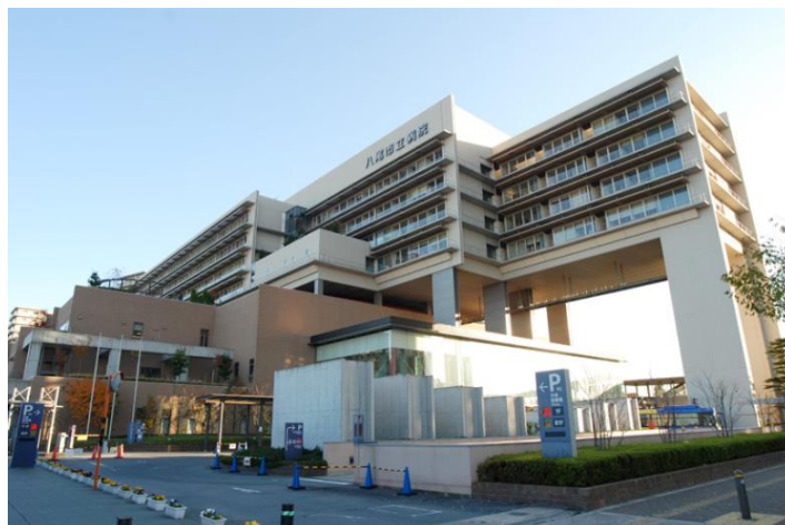
図表 28 八尾市立病院の外観
