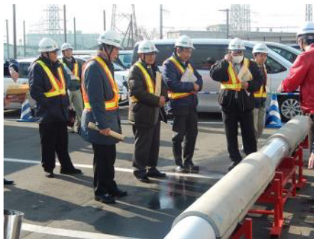
下水道管更生デモ（土木管理事務所）
