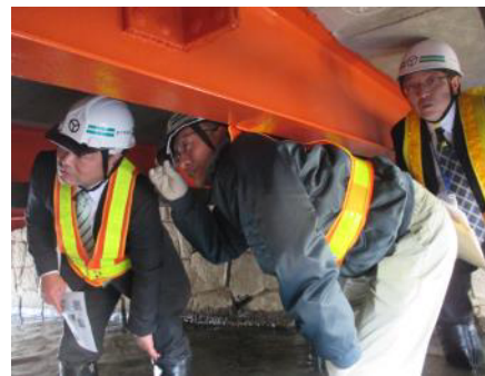
現地視察（旭橋）
