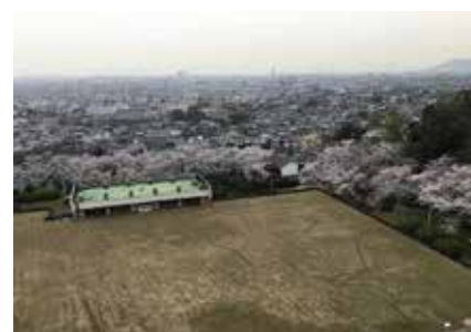
南部低区配水池は、高安受水場から受水・貯水し、市内南部の配水を担っている。
