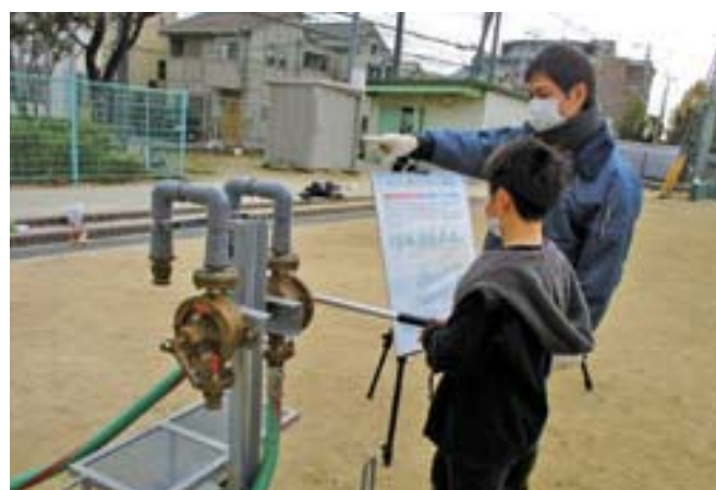
耐震性緊急貯水槽を用いた拠点給水の訓練
