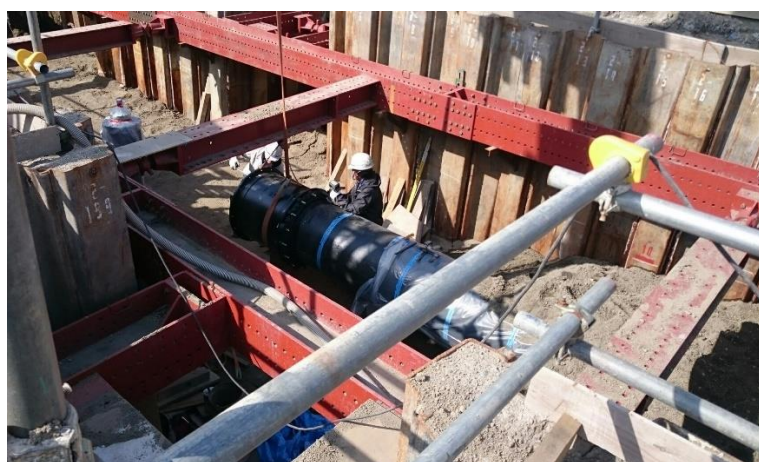
高安受水場内配管更新工事
