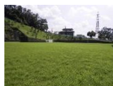
南部低区配水池(上部)
