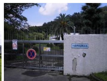
南部低区配水池
