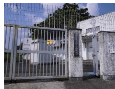
北部低区配水池
