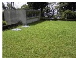
高区配水池(上部)
