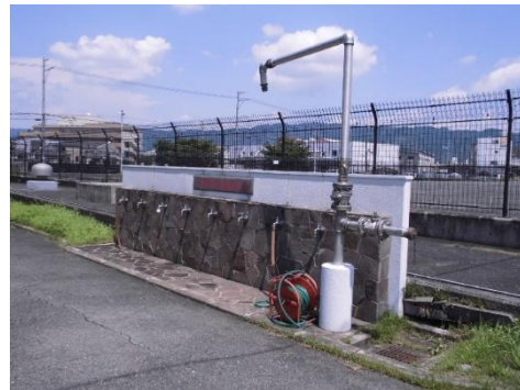
災害時用の応急給水栓
