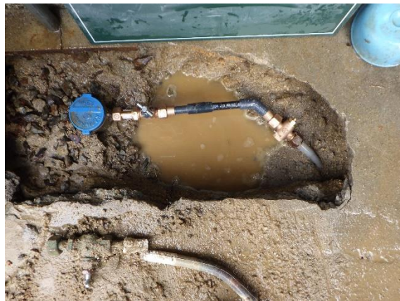
漏水修繕の際に鉛製給水管を取り替えています
