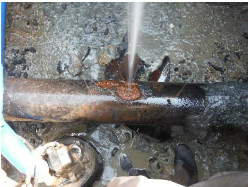
老朽化した鑄鉄管の漏水状況
