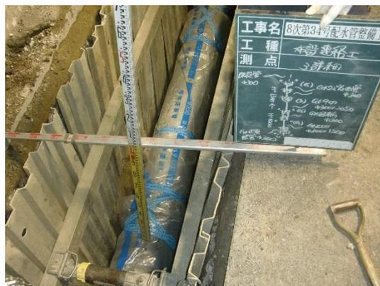
老朽化した铸铁管を撤去して耐震管に更新しています
