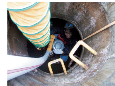
●あんしん給水栓を使用した応急給水訓練
