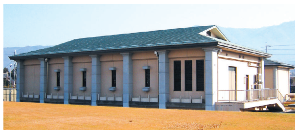
●高安受水場（配水ポンプ棟）
