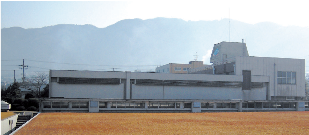
●高安受水場 (送水ポンプ棟)
