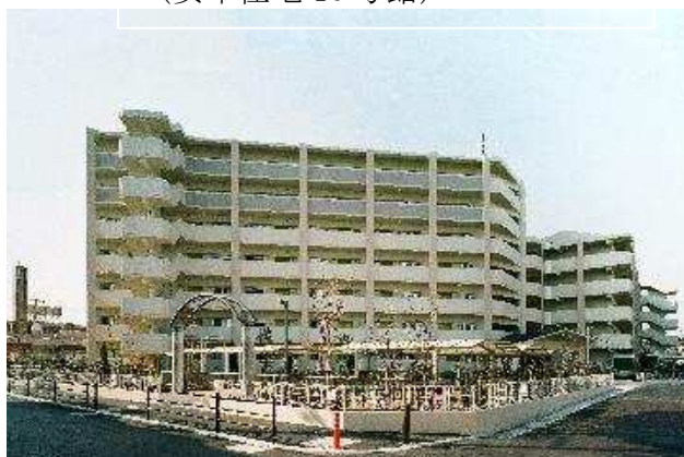
(安中住宅 16 号館)
