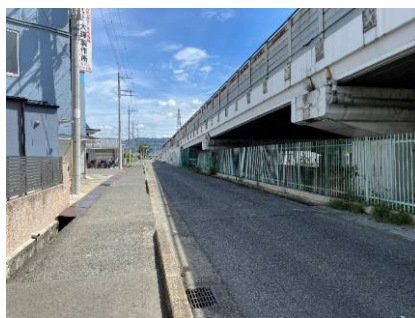
国道 170 号沿いの道路 （史跡指定地南側）
