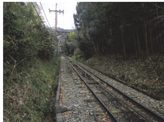
支群の中央を抜ける西信貴ケーブル
