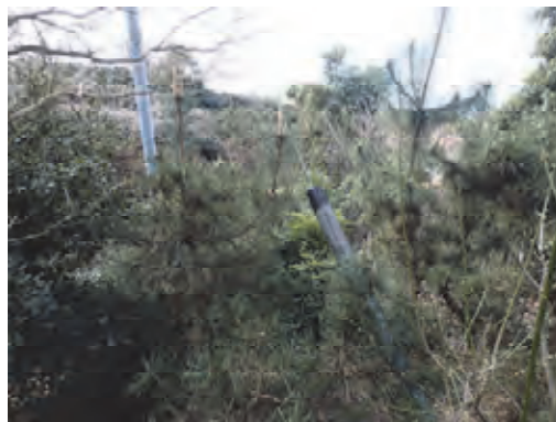
②電柱支線（服部川 33 号墳）
