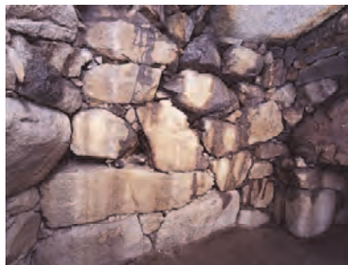
⑧郡川1号墳の左側壁
