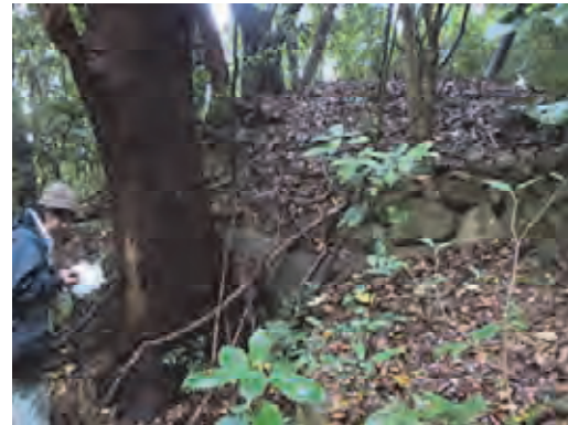
⑧ 開口部を塞いでいる樹木（服部川 93 号墳）
