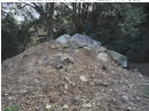
⑤ 盛土が流出しつつある古墳（服部川 77 号墳）
