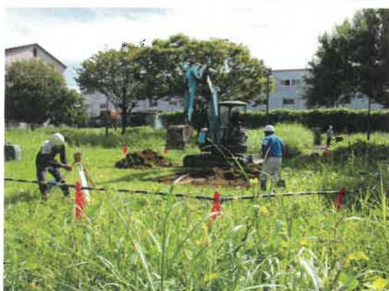
4区掘削状況(南西から)
