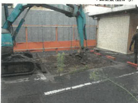
2区機械掘削状況(東から)
