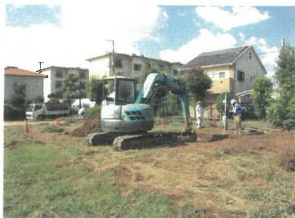
5区掘削状況(南東から)
