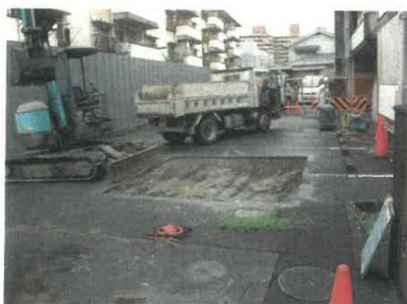
1区掘削前周辺状況(西から)
