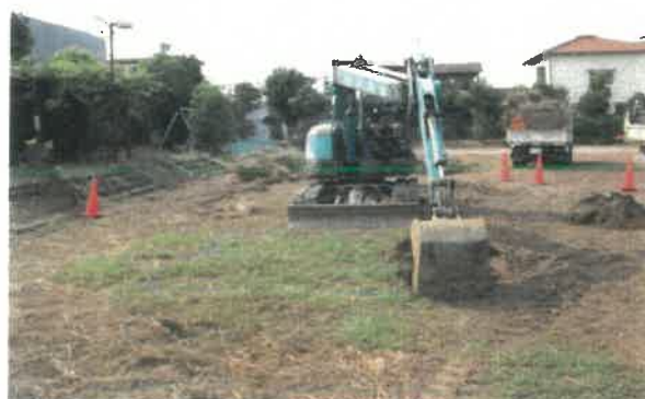
6区機械掘削状況(北から)
