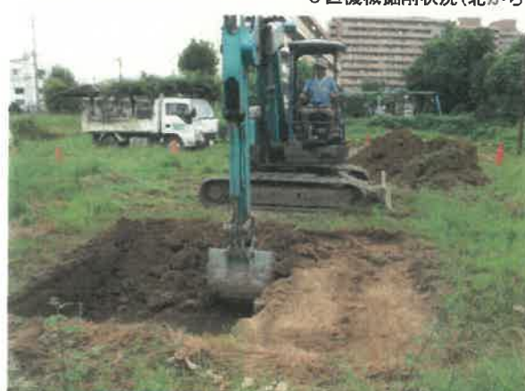
7区機械掘削状況周辺(西から)
