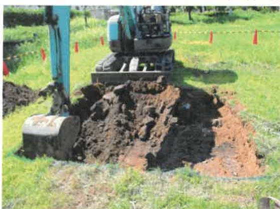
2区機械掘削状況(北から)
