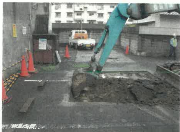
1区機械掘削状況(東から)
