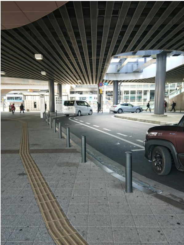
歩道セミフラット+車止め（JR 岡山駅西口駅前広場）
