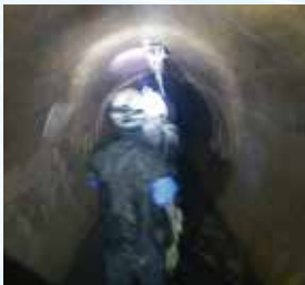
下水道管目視調査 空洞調査
