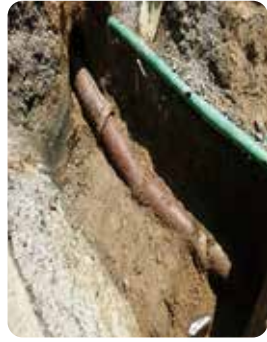
工事前(取付管)
