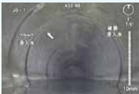
下水道管カメラ調査
