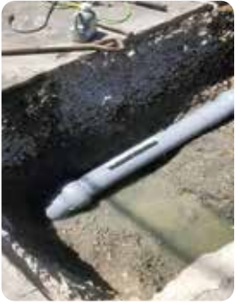
工事後(取付管)
