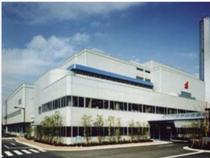
大阪広域環境施設組合(八尾工場)
