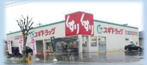
施工事例 スギ薬局 さま
