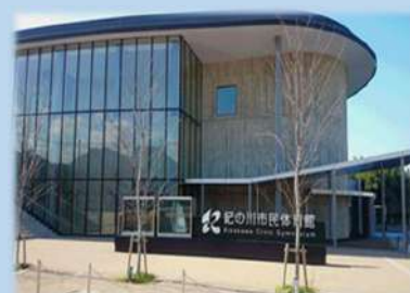
【施工例】紀ノ川市民体育館
