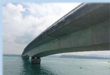
沖縄・古宇利大橋(全長1960m)に使用
