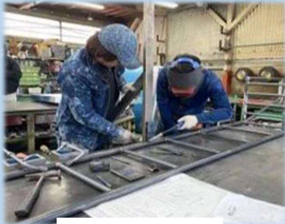
溶接工程(社屋)
