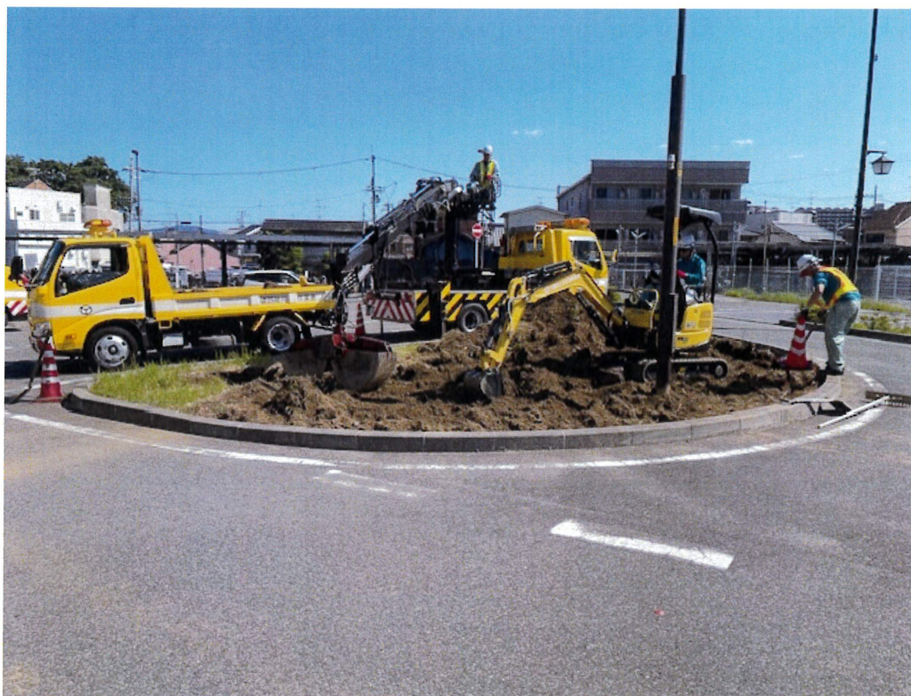
↑クレーンによる土砂積み込み状況 バックホウとの連携作業 (JR 八尾駅南側ロータリー) (市道竜華第 16 号線<植松町三丁目>)
