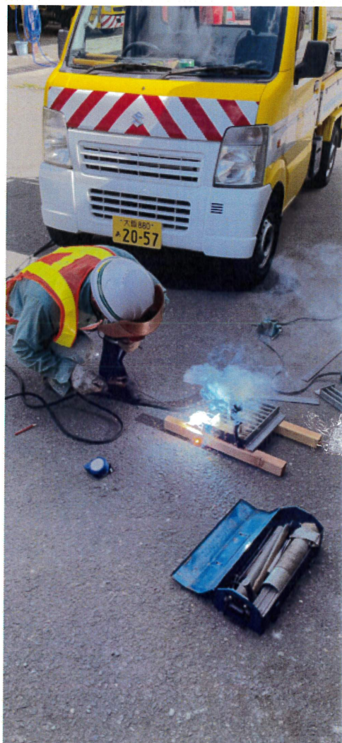
←アーク溶接作業時における 防じんマスク、遮光マスク着用による作業 (土木管理事務所内作業ヤード)
