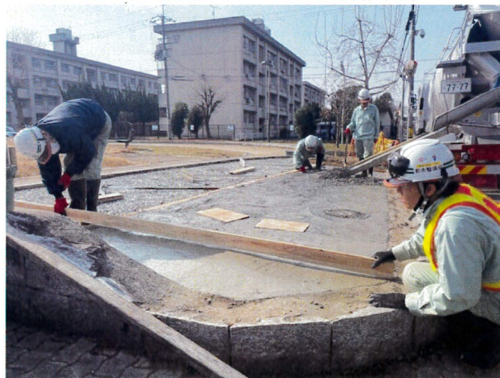
↑土間コンクリートならし状況（幸第2公園<幸町一丁目>）北側エントランス部）
