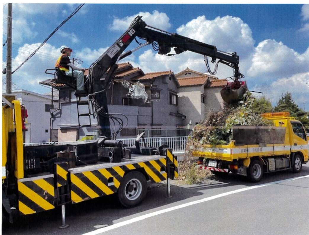
↑クレーンによる堆積土砂・雑草積み込み状況 (荒川右岸 市道高安第 85 号線 <郡川一丁目>)
