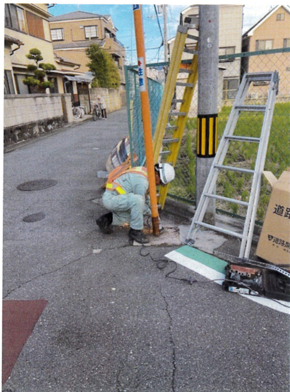
↑ 支柱切断状況
