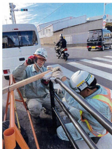
↑支柱・横ビーム柱を流用し設置、養生↑
