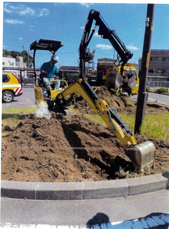
←バックホウによる掘削状況 (JR 八尾駅南側ロータリー) (市道竜華第 16 号線＜植松町三丁目＞)
