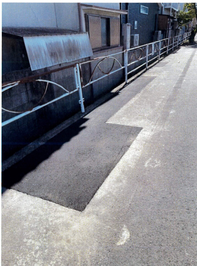
↑ 加熱アスファルト合材による道路舗装復旧竣工状況 市道山本第 362 号線 (上之島町五丁目)
