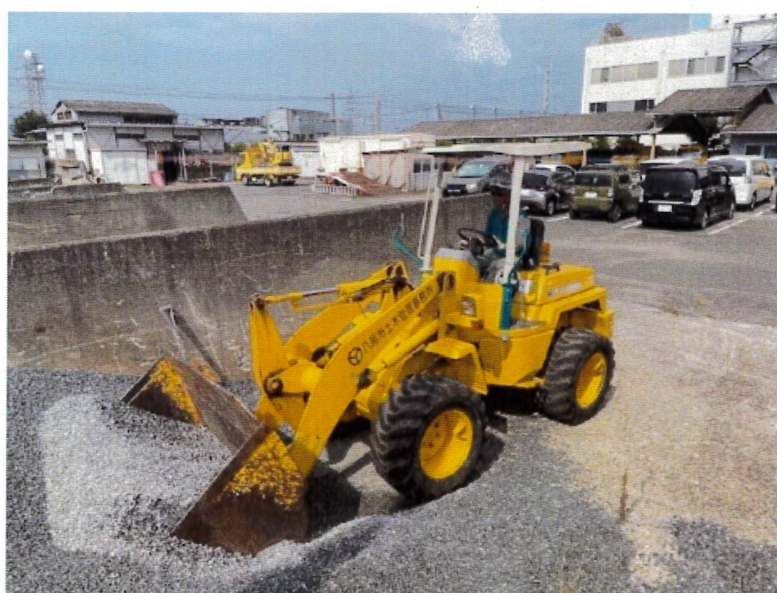
↑ ホイールローダーによる碎石積込み状況（土木管理事務所内資材保管ピット）
