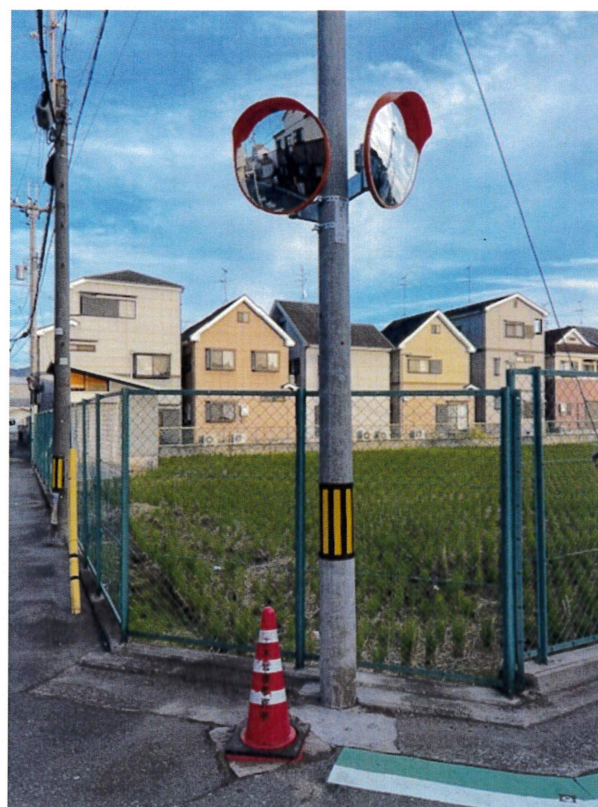
↑ 関電柱へ移設供架完了
