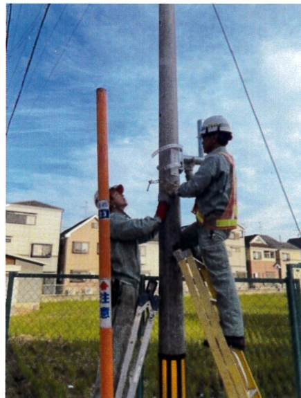
↑ カーブミラー取り付け金具の取り外し ↑
