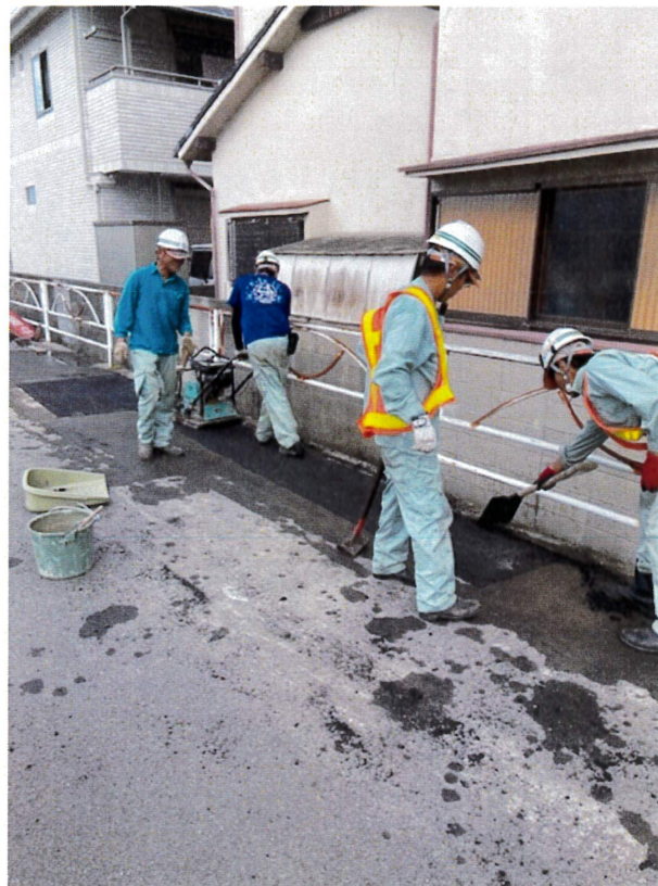
↑ 締固め状況 (振動プレート使用)
