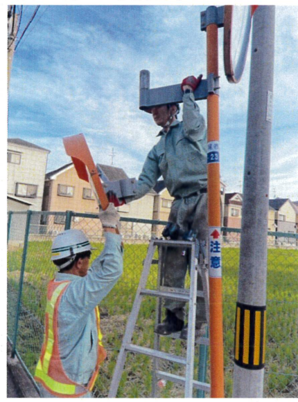
↑ カーブミラー鏡面の取り外し ↑
