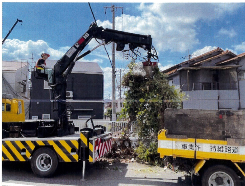
↑クレーンによる堆積土砂・雑草積込み状況 (荒川右岸 市道高安第 85 号線 <郡川一丁目>)
