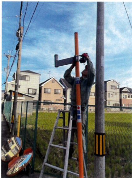
↑ カーブミラー取り付け金具の取り外し ↑
