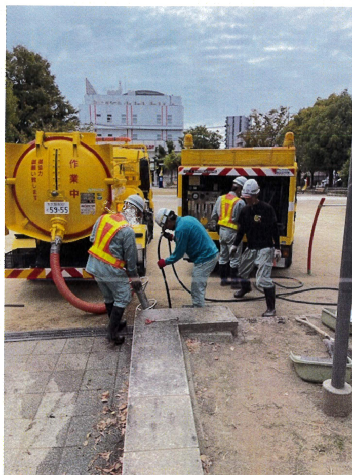
↑ 高圧洗浄（ハイプレクリーナー）、吸引（パワフルマスター）連携作業 ↑
