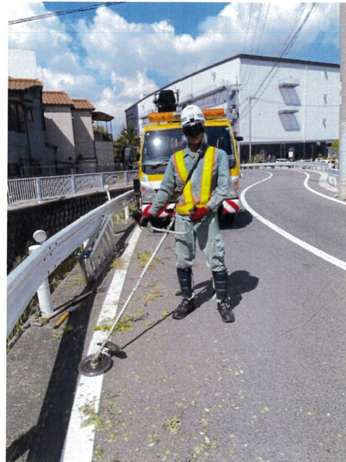
↑ 除草作業プロテクター装着状況 荒川右岸（市道高安第126号線＜郡川一丁目＞）
