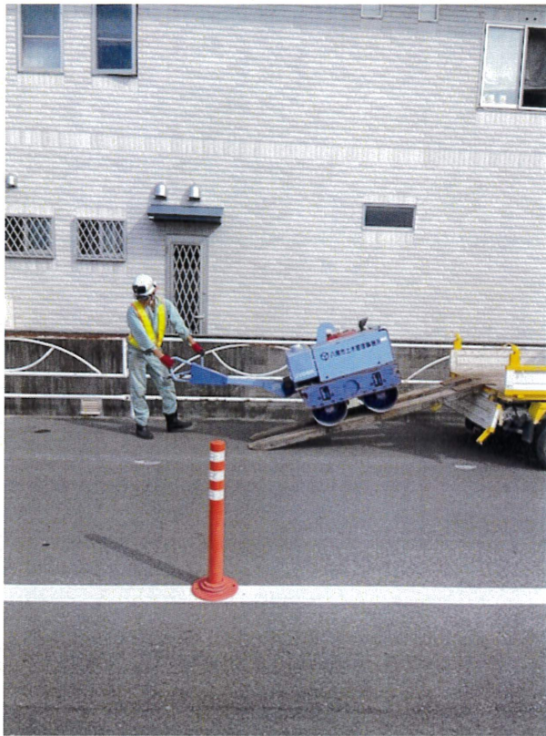
↑ハンドガイドローラー積み降ろし状況
