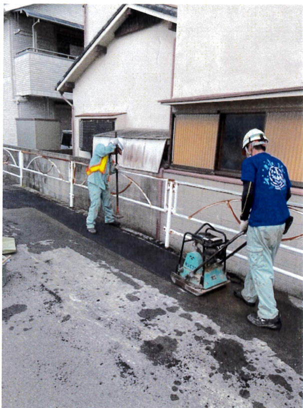
↑ 締固め状況 (振動プレート、アスファルトタンパー使用)
