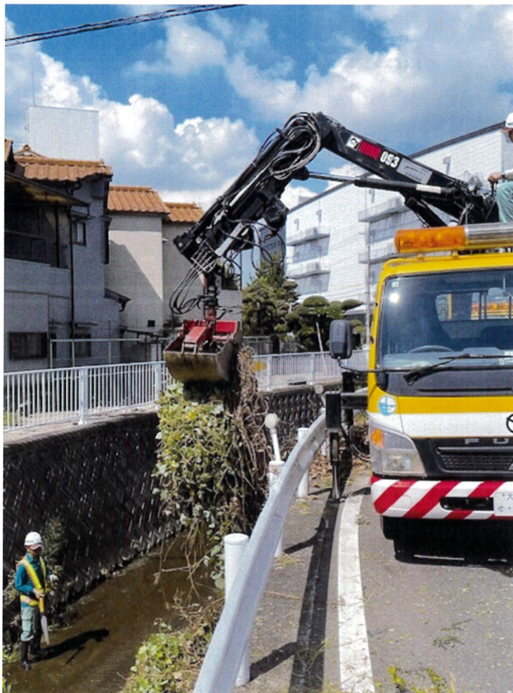
↑クレーンによる堆積土砂・雑草積込み状況 (荒川右岸 市道高安第 85 号線 <郡川一丁目>)
