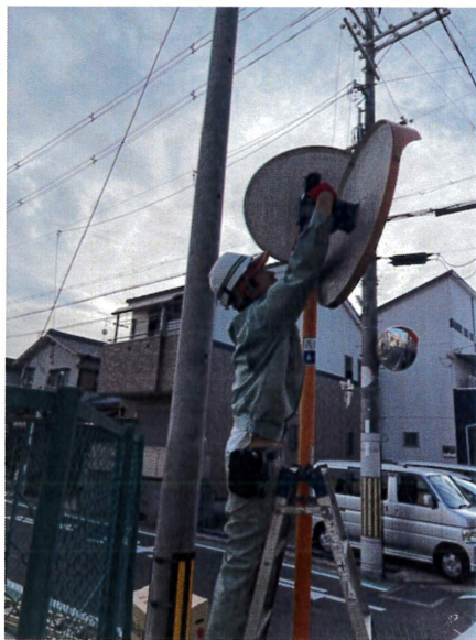
↑ カーブミラー鏡面の取り外し ↑
