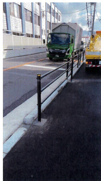
↑表面モルタル仕上げ状況 ↑養生後補修完了状況 既存ストック資機材を有効活用し傷んだ横断防止柵を補修設置しました。 (市道木の本田井中線<老原4丁目>)
