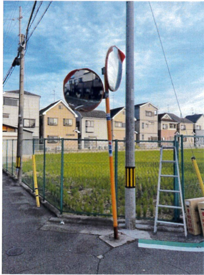
↑ 根腐れにより傾いているカーブミラー支柱 ↑
