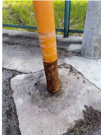
↑ 根腐れにより傾いているカーブミラー支柱 ↑
