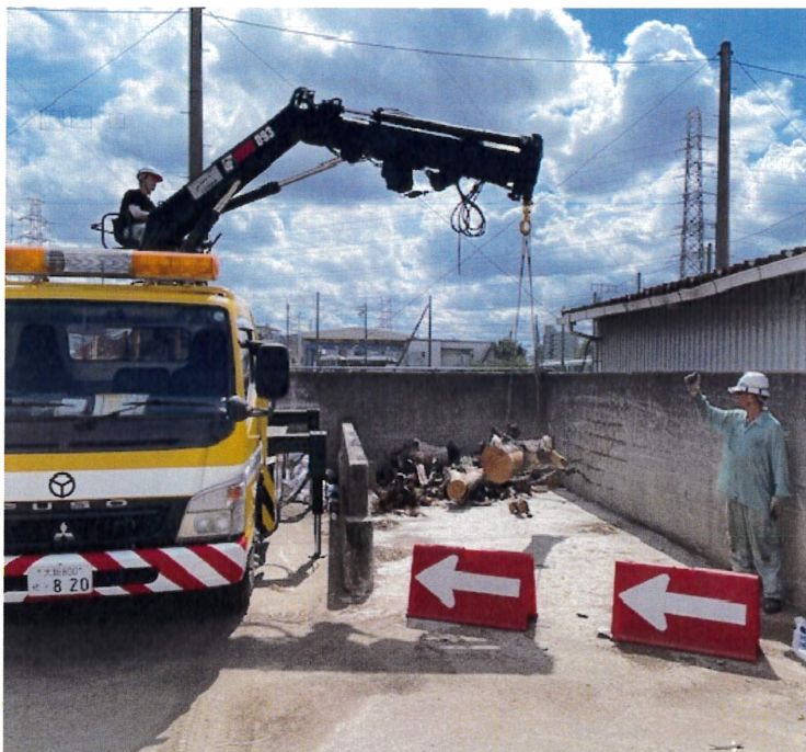
↑ 玉掛け合図状況 (土木管理事務所内ピット) ↑
