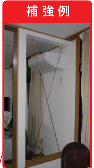
補強例 露出仕上げ 部屋を広く見せるため、柱と筋交いを露出した補強を行いました。
