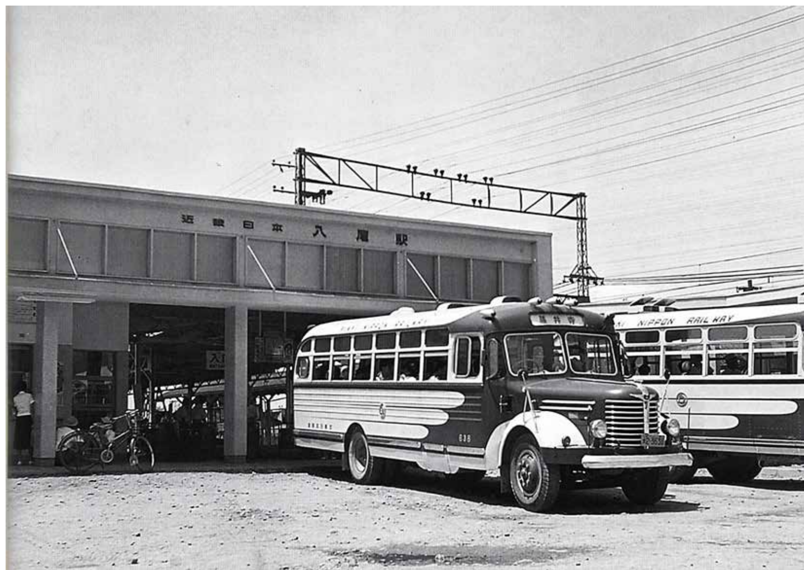
近鉄八尾駅1957年（昭和32年）頃現在の駅の300m西にあった。
