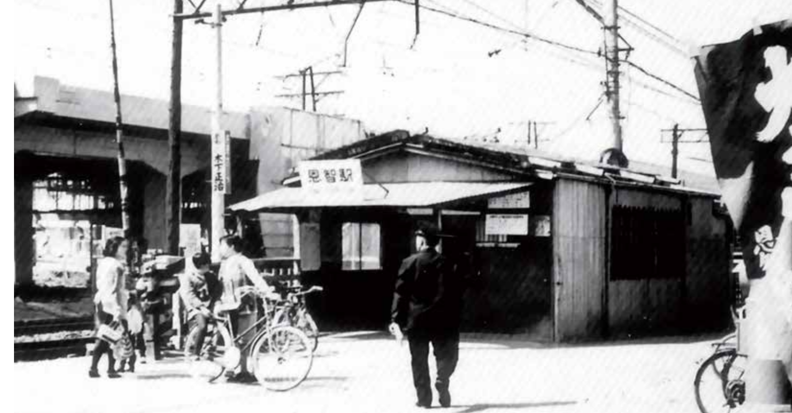
近鉄 恩智駅 昭和 40 年代前半 高架化工事中
