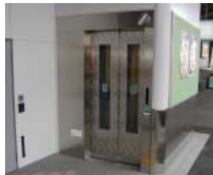
事例：エレベーターの設置
