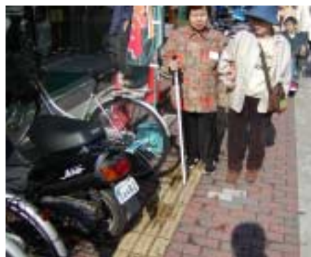
事例：歩道部の不法占拠物
