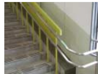
写真: 階段手すりの2段化 (図3参照)
