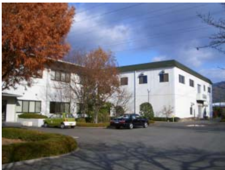
(八尾市立衛生処理場)
