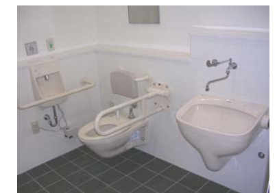
多機能トイレの設置・改良例
