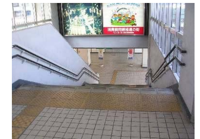
手すりの改良例
