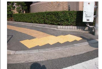
視覚障害者誘導用ブロックの適切な設置例
