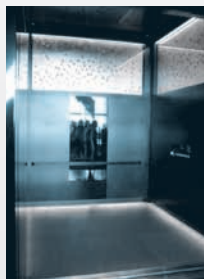
▲東京スカイツリーのエレベーター。壁の黒い部分がアベルブラック。
