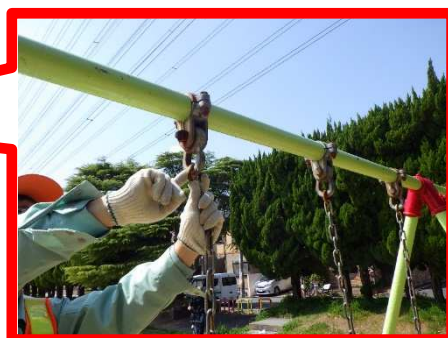
複合遊具のボルトゆるみ確認
