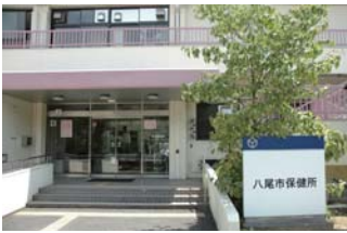
平成30年度から市の所管となった保健所
