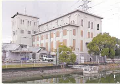
旧八尾変電所(老原)
