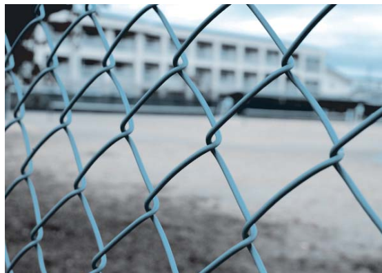
学校や通学路のブロック塀をフェンス等へと改修する工事が進んでいる。
