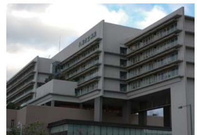
新たに15年のPFI事業の契約を結ぶ八尾市立病院
