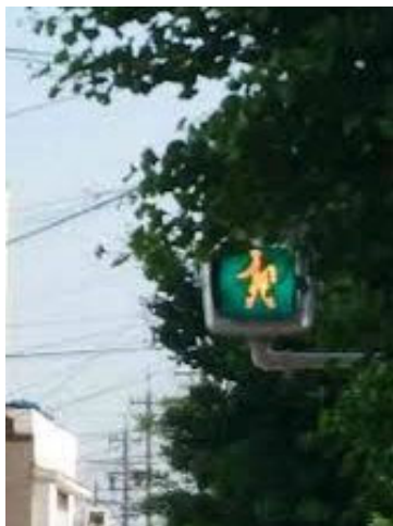
交通安全・交通管理施設の視認性の低下（信号機・道路照明灯・道路標識）
