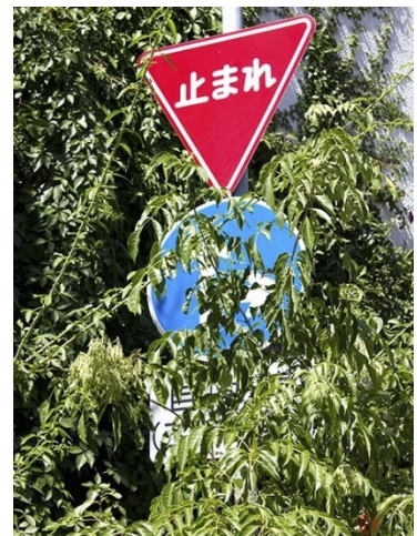
交通安全・交通管理施設の視認性の低下（信号機・道路照明灯・道路標識）
