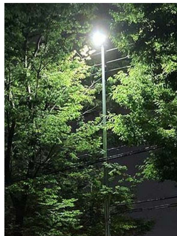
交通安全・交通管理施設の視認性の低下（信号機・道路照明灯・道路標識）
