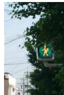
交通安全・交通管理施設の視認性の低下（信号機・道路照明灯・道路標識）
