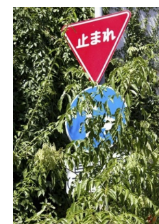
交通安全・交通管理施設の視認性の低下（信号機・道路照明灯・道路標識）
