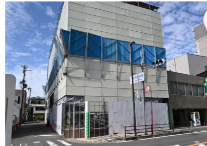
旧八尾図書館は現在解体中であり今年度中に更地になる予定である。
