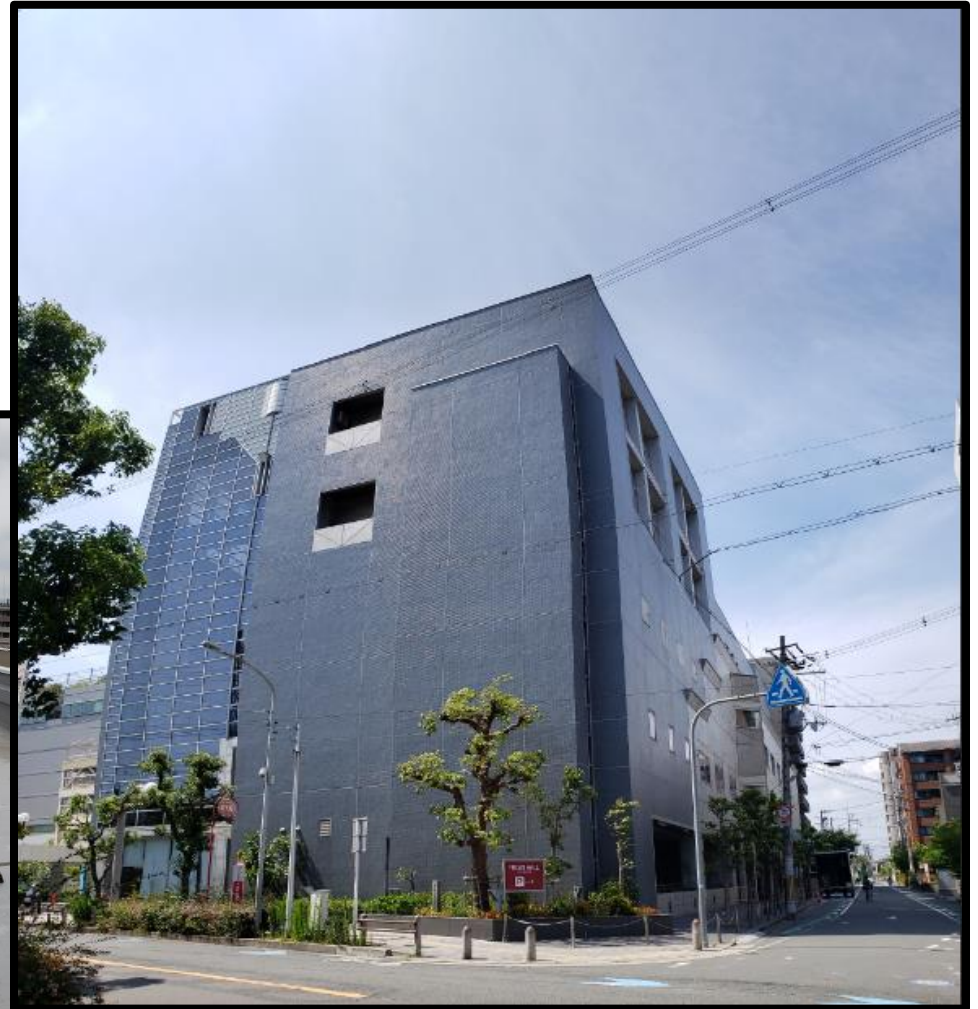
外壁タイル面等の改修
