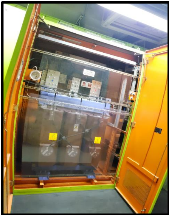
受変電設備の更新
