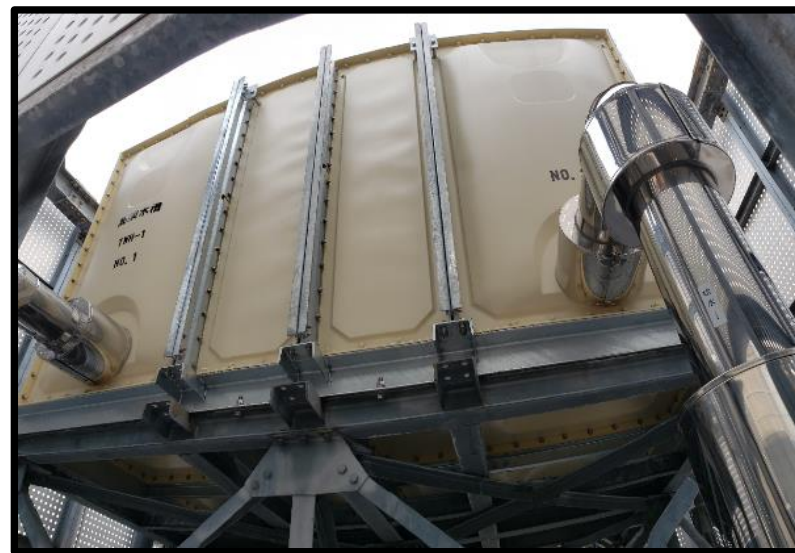
給水タンクの更新
