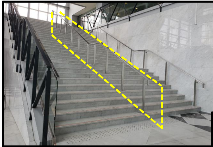
大ホール 大階段手摺増設
