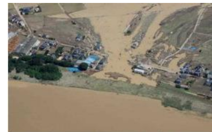
堤防決壊による家屋の流失(鬼怒川)
