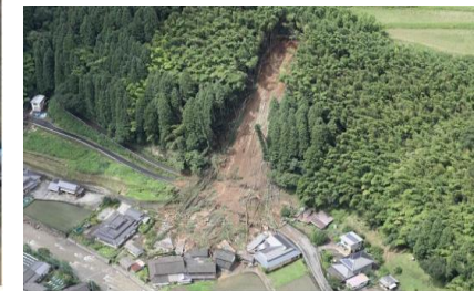
写真2 土砂災害による建物被害の例(大分県日田市令和2年7月)
