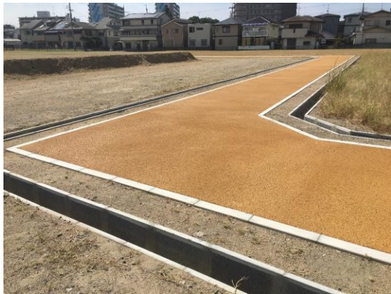
管理用通路（中央東側付近）
