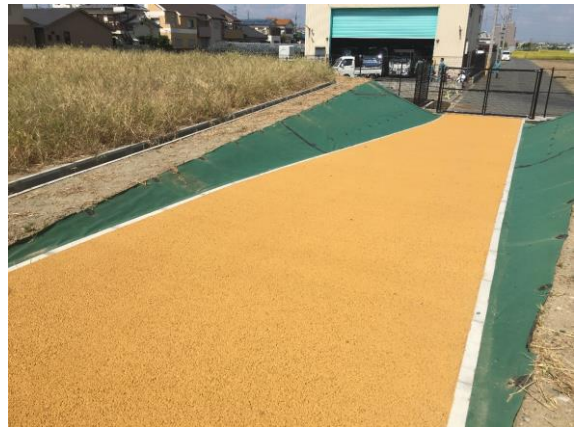
管理用通路（北側出入口）
