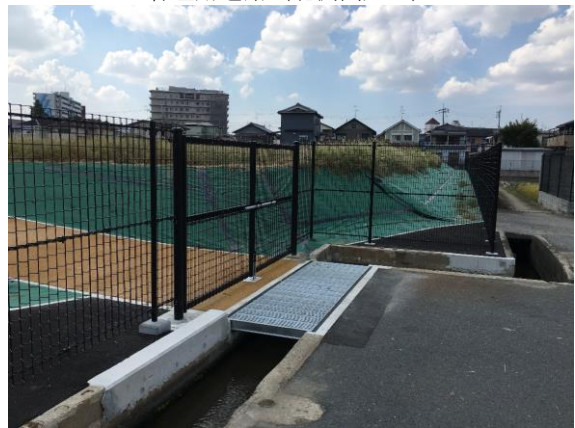
侵入防止のフェンス
