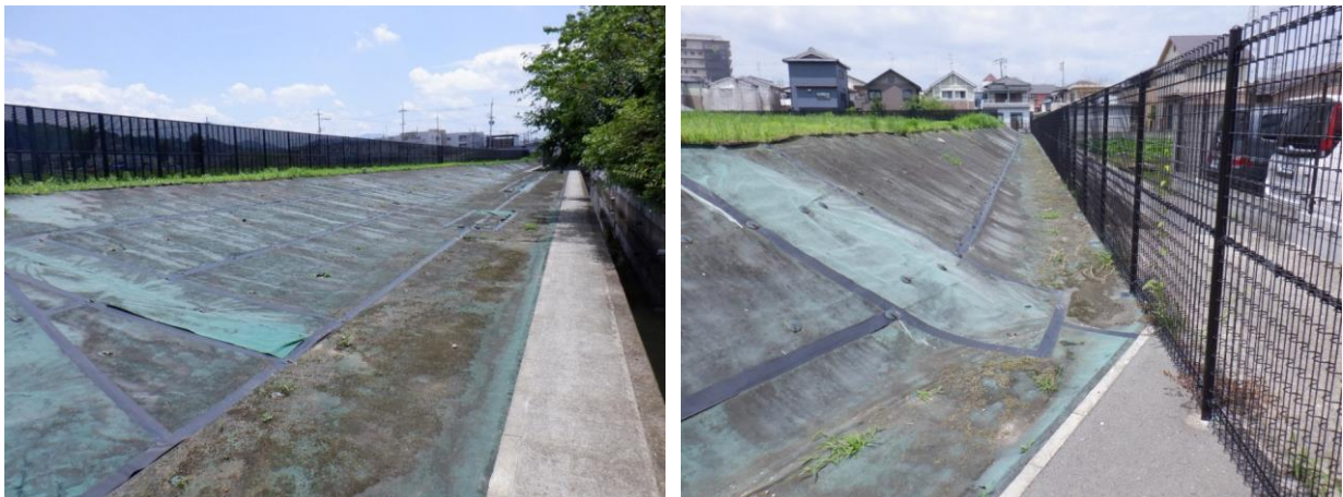
図 3-27 史跡指定地内法面（左：西側境界、右：北側境界）（令和 4 年 6 月現在）
