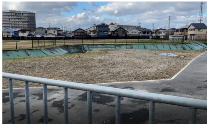
歩道北側から
