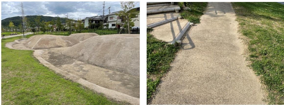
図 5-20 土系舗装の事例（左：安満遺跡公園、右：史跡大山崎瓦窯跡（大山崎町））
