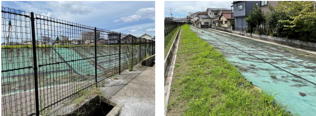
図 5-17 緩衝ゾーン北側と西側の法面の現状
