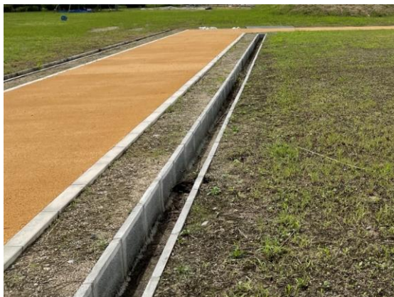
図 5-21 史跡指定地内で整備済みの雨水排水路
